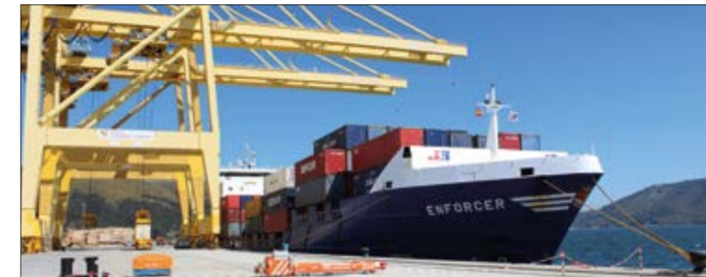
Terminal de contenedores del puerto de Ferrol
