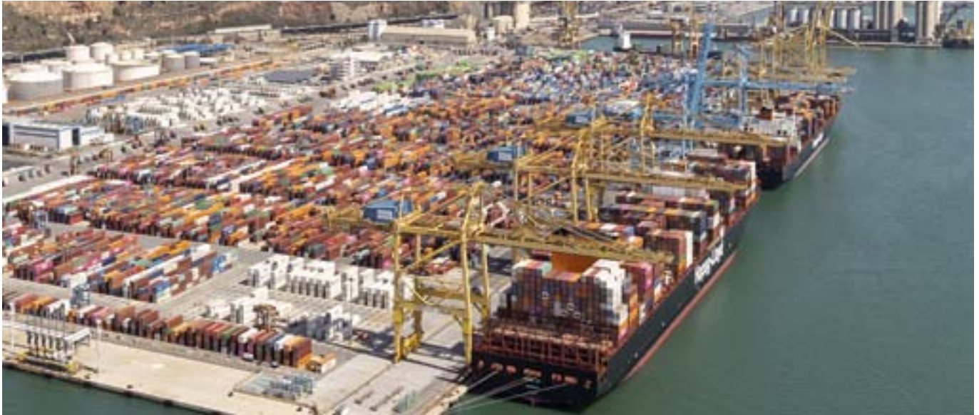
Terminal de contenedores en el Port de Barcelona
